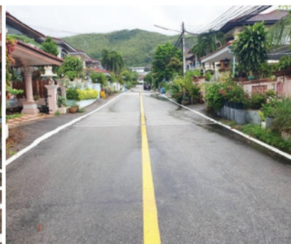
โครงการตรวจรับโครงการจ้างเหมาตีเส้นจราจร และเครื่องหมายบนพื้นทางบริเวณถนน และซอยในเขตเทศบาลเมืองสัทธิ์
