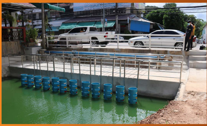
โครงการปรับปรุงฝายทดน้ำ บริเวณลำห้วยหนองตะเคียน ช้างร้านสุขุมวิท งบประมาณดำเนินงาน 730,000 บาท
