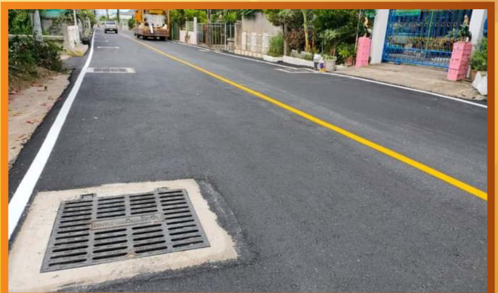
โครงการปรับปรุงผิวจราจรแอสฟัลท์ติกคอนกรีต บริเวณซอยสี่หีบสุขุมวิท 105 (หนองหญ้า) งบประมาณดำเนินงาน 2,340,000 บาท
