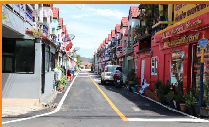
โครงการปรับปรุงถนนพร้อมวางท่อระบายน้ำ บริเวณซอยสี่หีบสุขุมวิท 73/3 (พัฒนาบ่อนไก่) งบประมาณดำเนินงาน 1,350,000 บาท
