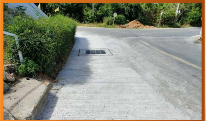
โครงการวางท่อระบายน้ำพร้อมบ่อพัก ซอยสี่หีบสุขุมวิท 85 (เขาน้อย) งบประมาณดำเนินงาน 220,000 บาท
