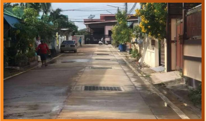
โครงการปรับปรุงระบบระบายน้ำ ซอยสี่หีบสุขุมวิท 99/2 งบประมาณดำเนินงาน 500,000 บาท
